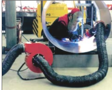
Tragbarer Ventilator mit magnetischer Saugdüse während des Schweißens.
